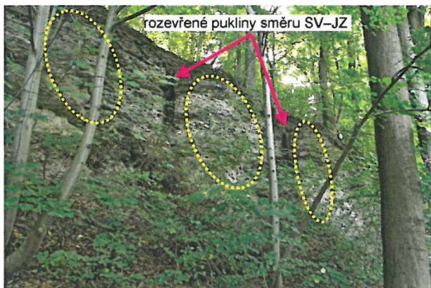
Foto 15 Další ukázka stabilizace výchozů v západní části zájmového území. Ve žlutých tečkovaných elipsách jsou zvýrazněny skalní objekty určené k zajištění kotvami.
