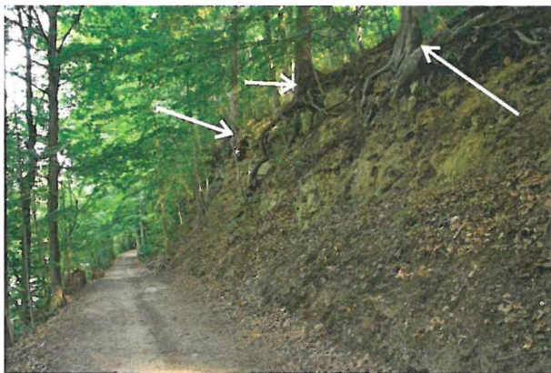
Foto 16 Pohled ze západního okraje zájmového území k východu, kde dojde k odstranění vzrostlých stromů a odtěžení nestabilních objektů i zajištění částí kotvením, které ale v současnosti vzhledem k dezintegraci masivu nelze jednoznačně vyznačit, resp. označit ty, které zůstanou zachovány.
