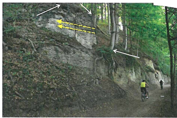
Foto 6 Žluté přerušované šipky naznačují směr kotvení skalního bloku (Klinčůch – Holý 2018). Bílé šipky ukazují na stromy s negativním dezintegračním vlivem, které budou odstraněny.
