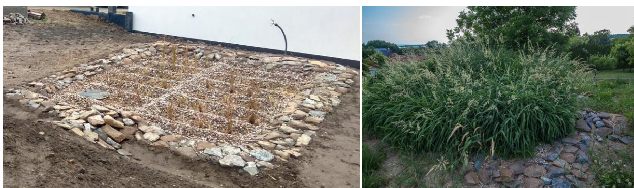
Obrázek 3 - Vertikální filtr – před a po osazení mokřadními rostlinami
