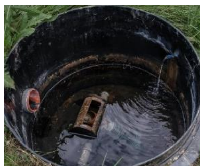
Obr.: Pulzní šachta - vypustný plovákový mechanismem, opláštění
