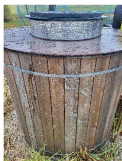
Obr.: Pulzní šachta - vypustný plovákový mechanismem, opláštění
