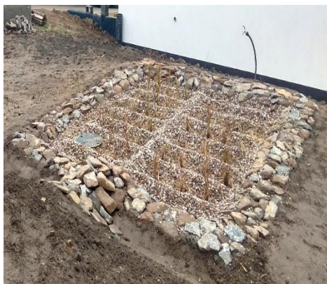
Obr.: Vertikální filtr pro čištění odpadních vod z domácností (vlevo – před osázením, vpravo – po osázení rostlinami)
