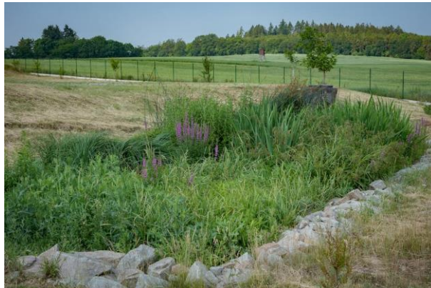
Obr.: Vertikální filtr pro čištění odpadních vod z domácností (vlevo – před osázením, vpravo – po osázení rostlinami)
