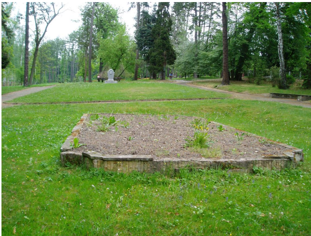
D3 - záhon - betonový sokl s kamenným obkladem
