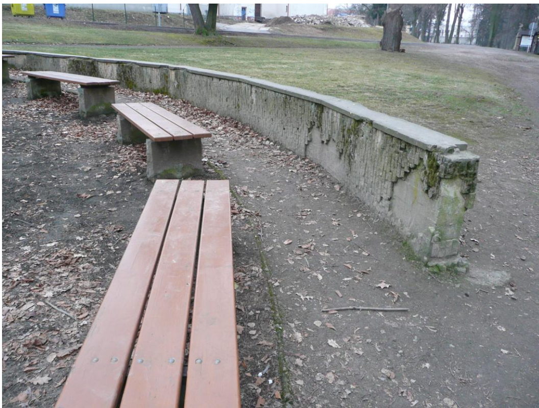
D1 - betonová oblouková zídka obložena kamenným obkladem (demolice včetně základů)
