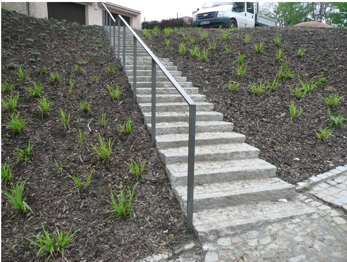
Ilustrační fotografie – terénní schody (žulová štípaná dlažba, žulová štípaná obruba)
