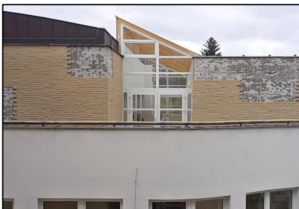
pohledy z hlavní budovy
