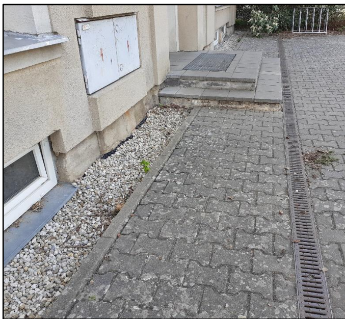
úprava terénu kolem soklu budovy
