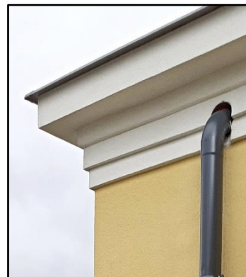
nová římsa výtahu
