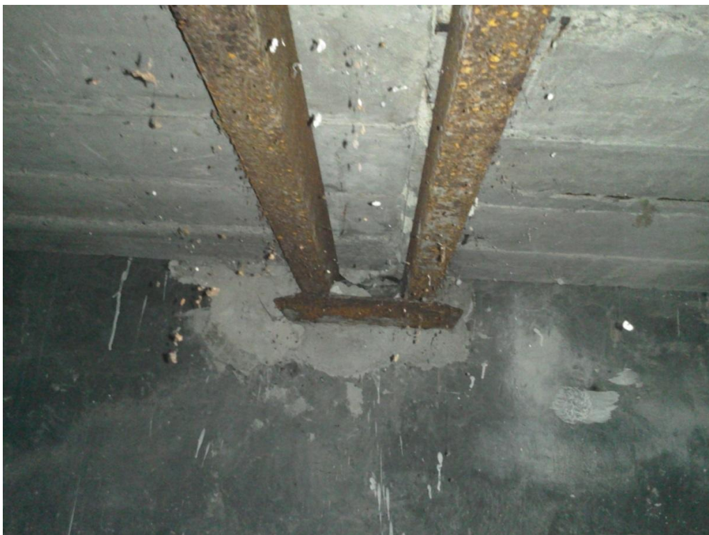
Obr. č. 03 – Nosná konstrukce stropu v podsklepené části
