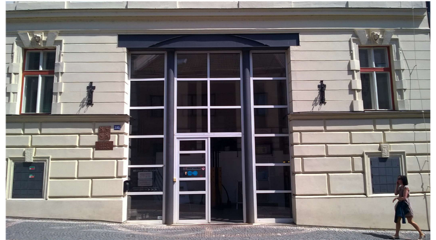
Stávající stav: plastové výplně; přiznané litinové sloupy a překlad.
